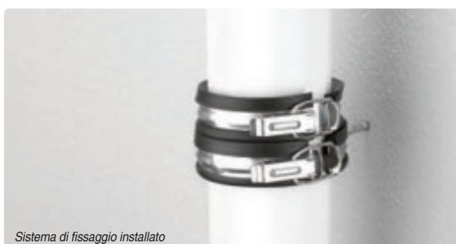
Chiudere la fascetta di sostegno
